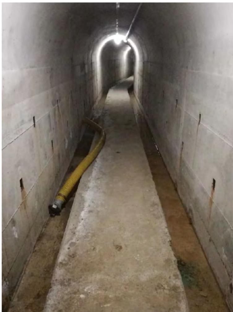
Figura 7.4: Diga di Gibbesi – Cunicolo drenaggio Ovest
