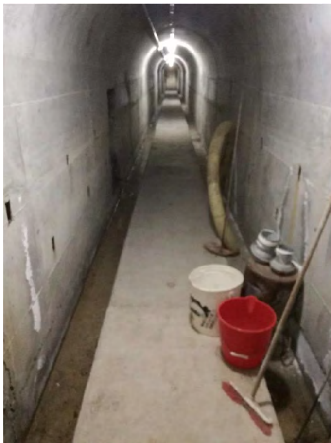
Figura 7.5: Diga di Gibbesi – Cunicolo drenaggio Est
