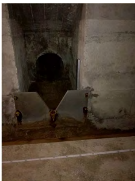
Figura 7.6: Diga di Gibbesi – Particolare innesto tipo del canale di drenaggio nel cunicolo
